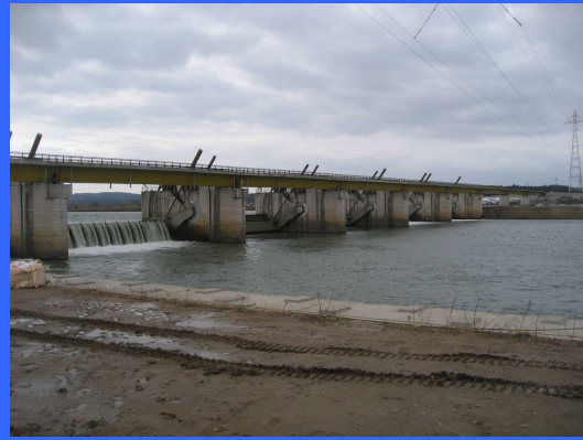
③ 右岸仮締切りより
