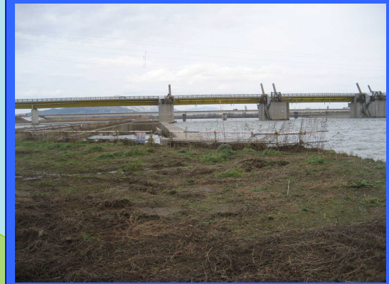
② 左岸魚道上流より
