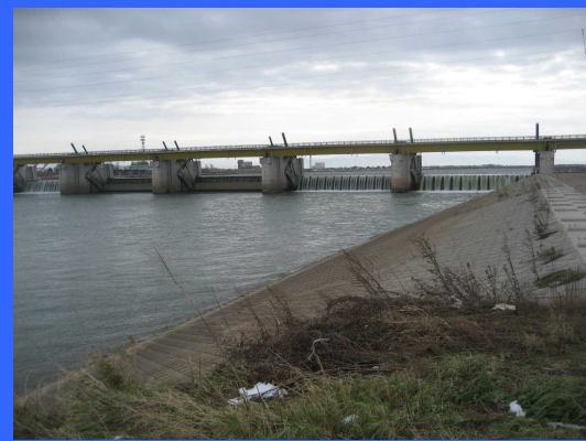
④ 左岸魚道下流より
