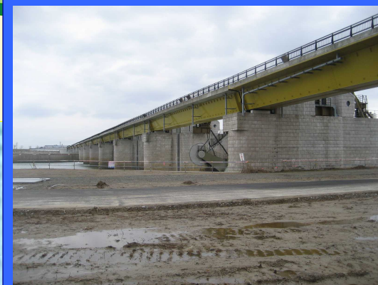
① 左岸仮締切りより
