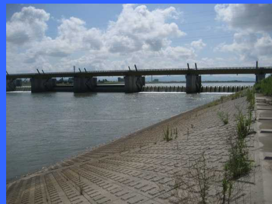
④ 左岸魚道下流より
