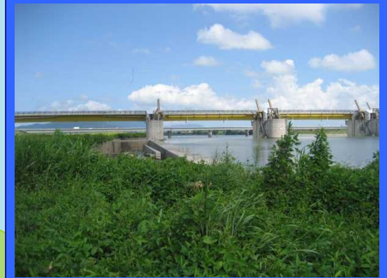
② 左岸魚道上流より
