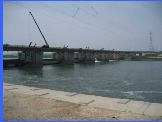
③ 右岸仮締切りより
