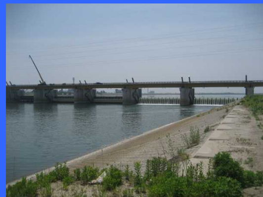
④ 左岸魚道下流より
