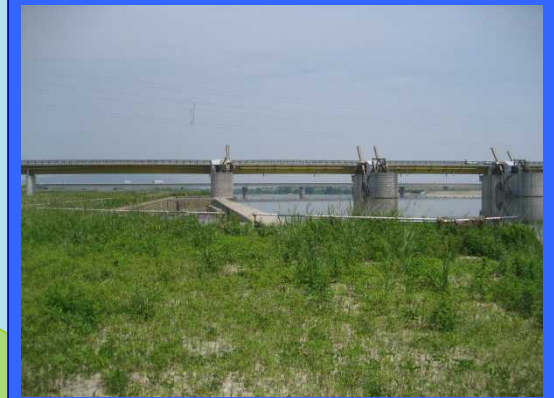
② 左岸魚道上流より
