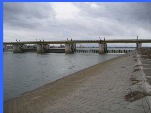
④ 左岸魚道下流より
