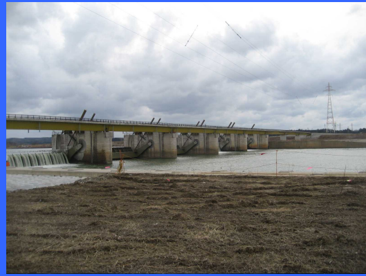
③ 右岸仮締切りより
