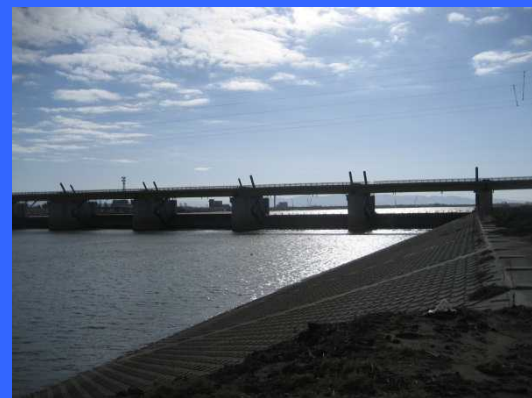
④ 左岸魚道下流より
