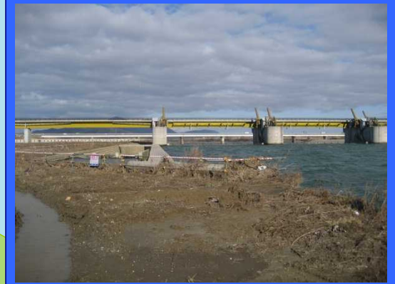
② 左岸魚道上流より
