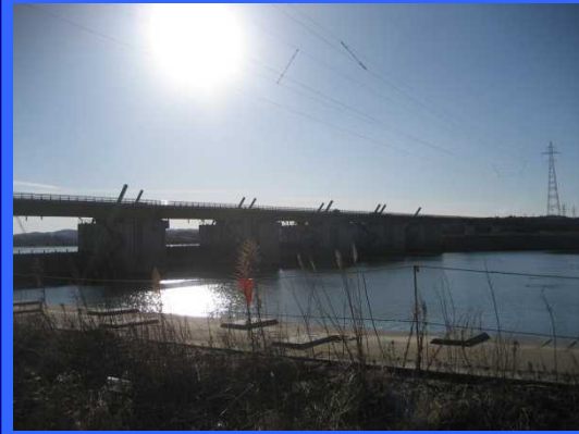
③ 右岸仮締切りより
