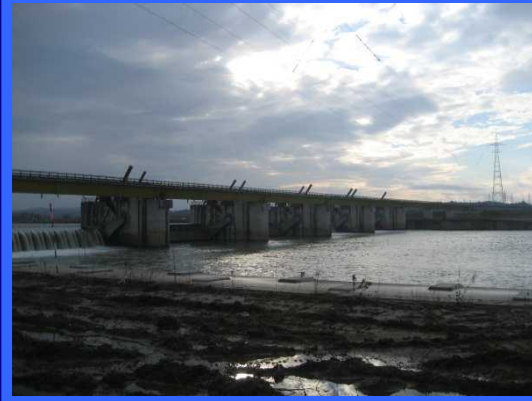
③ 右岸仮締切りより
