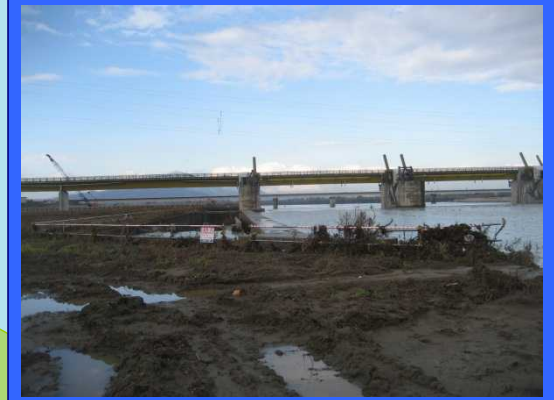
② 左岸魚道上流より
