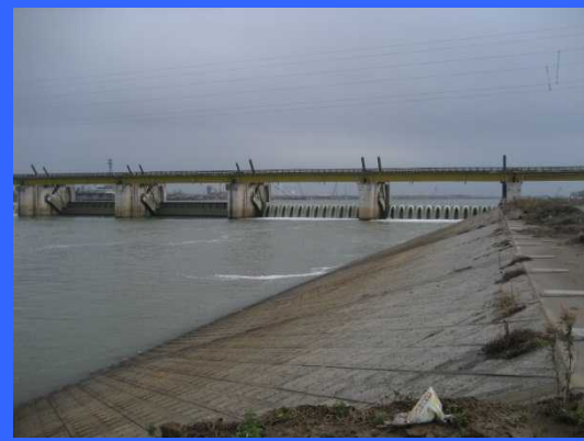
④ 左岸魚道下流より
