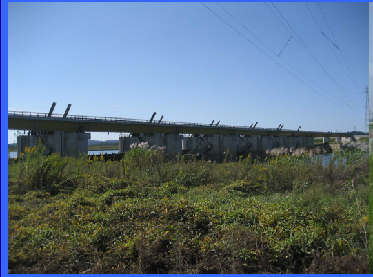
③ 右岸仮締切りより
