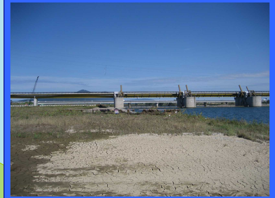
② 左岸魚道上流より
