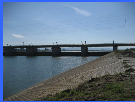
④ 左岸魚道下流より
