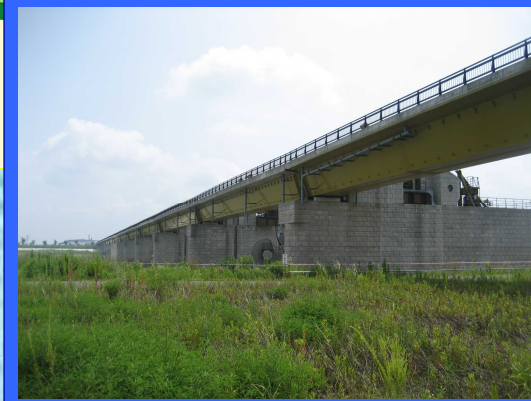
① 左岸仮締切りより
