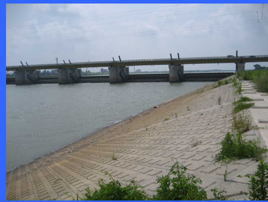
④ 左岸魚道下流より
