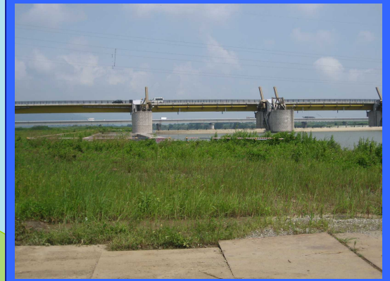
② 左岸魚道上流より
