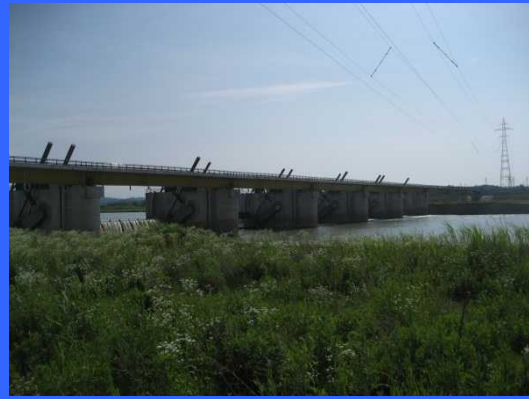
③ 右岸仮締切りより
