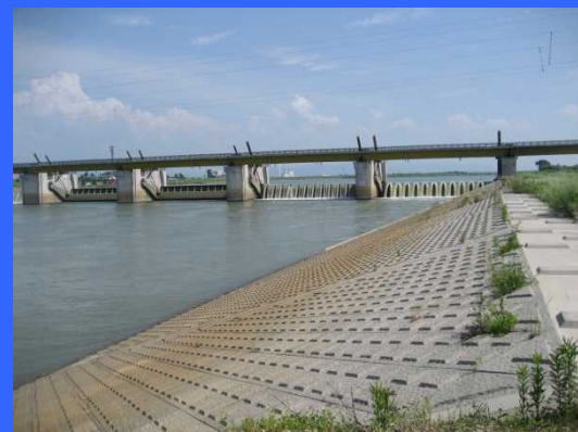
④ 左岸魚道下流より
