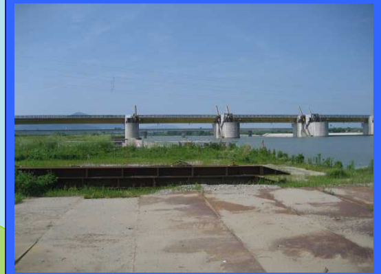
② 左岸魚道上流より
