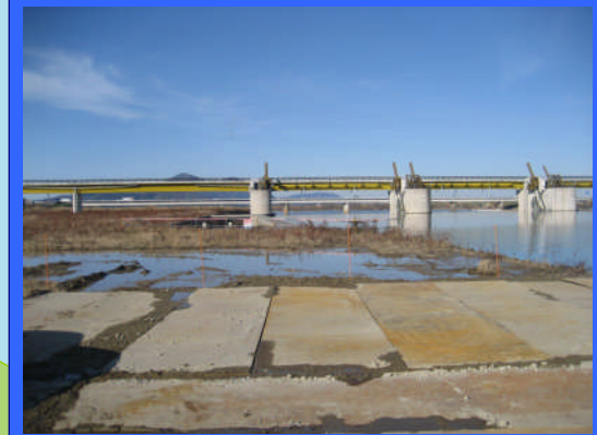
② 左岸魚道上流より
