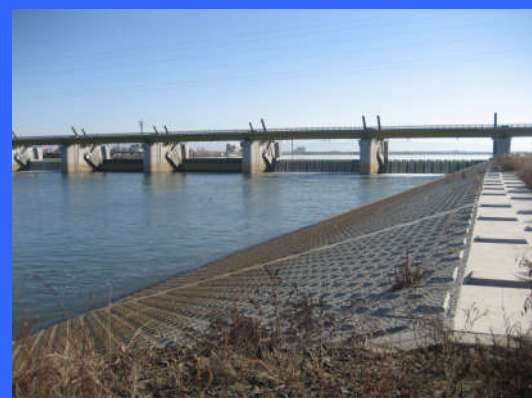
④ 左岸魚道下流より
