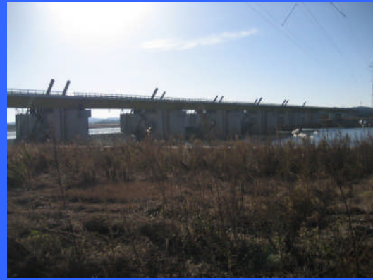
③ 右岸仮締切りより
