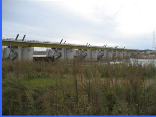
③ 右岸仮締切りより
