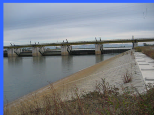
④ 左岸魚道下流より
