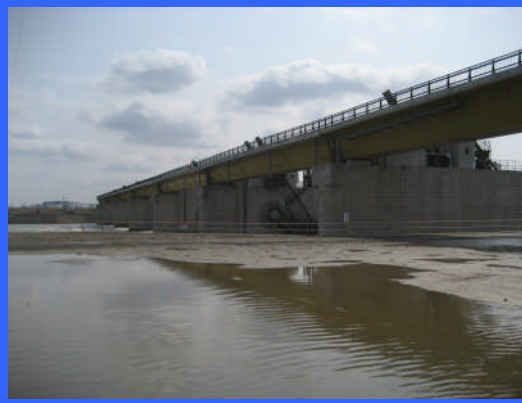
① 左岸仮締切りより
