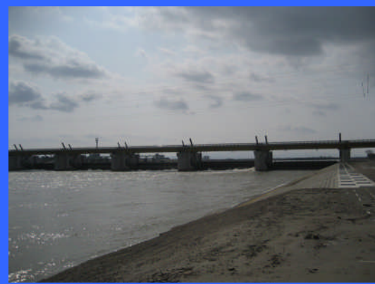
④ 左岸魚道下流より
