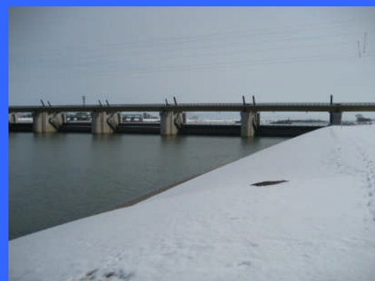
④ 左岸魚道下流より
