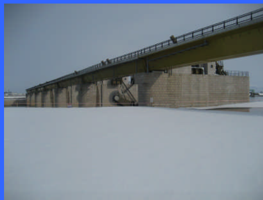
① 左岸仮締切りより
