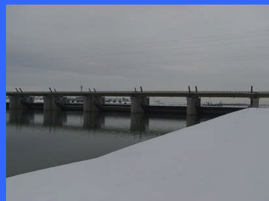
④ 左岸魚道下流より
