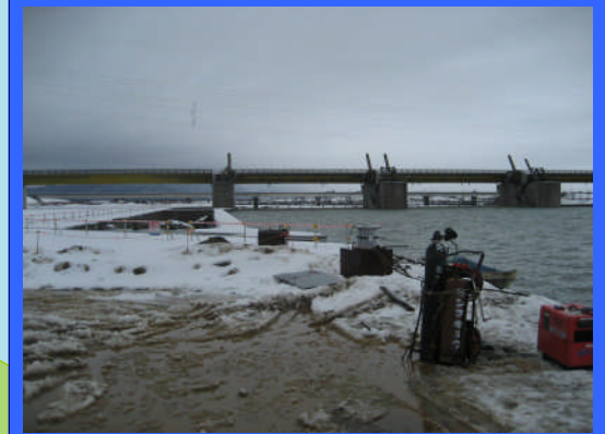
② 左岸魚道上流より
