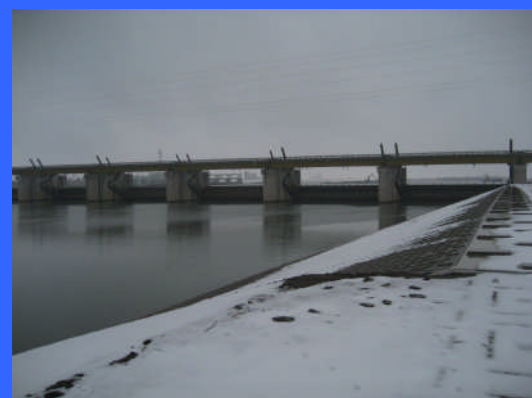
④ 左岸魚道下流より
