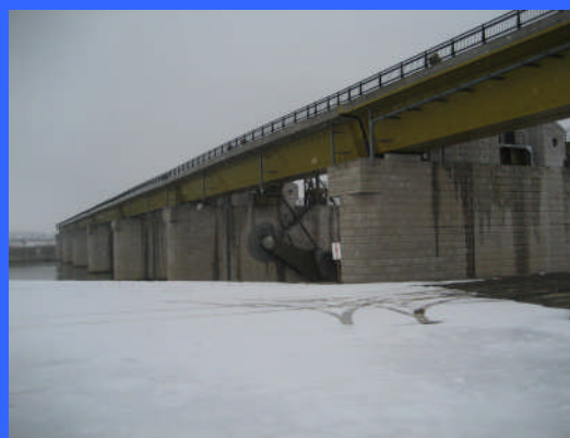
① 左岸仮締切りより
