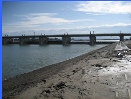
④ 左岸魚道下流より
