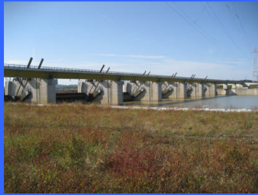
③ 右岸仮締切りより
