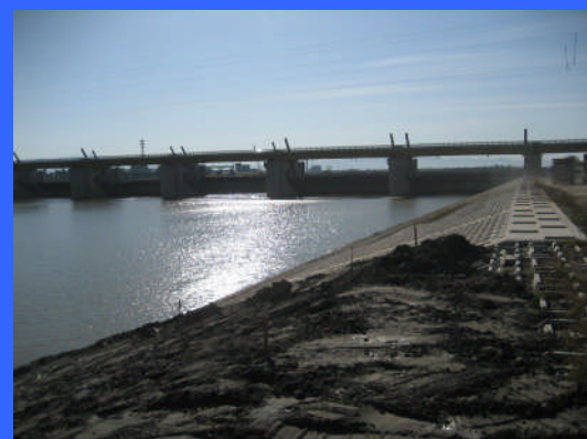
④ 左岸魚道下流より
