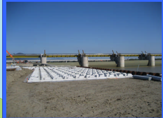
② 左岸魚道上流より
