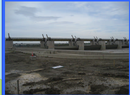
② 左岸魚道上流より
