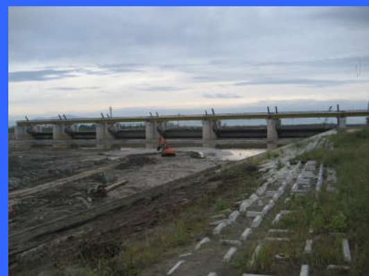
④ 左岸魚道下流より
