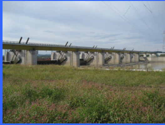
③ 右岸仮締切りより
