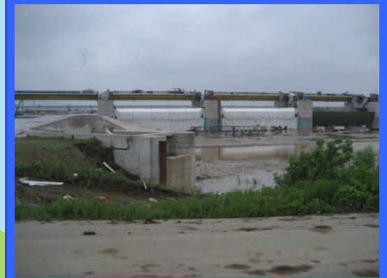
② 左岸魚道上流より
