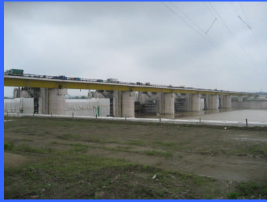
③ 右岸仮締切りより
