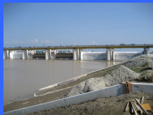
④ 左岸魚道下流より
