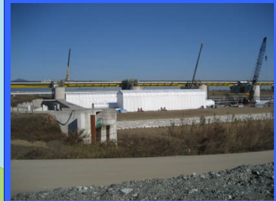
② 左岸魚道上流より
