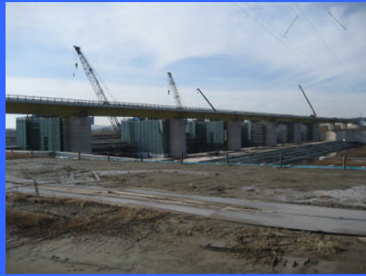
③ 右岸仮締切りより
