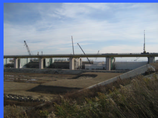
④ 左岸魚道下流より
