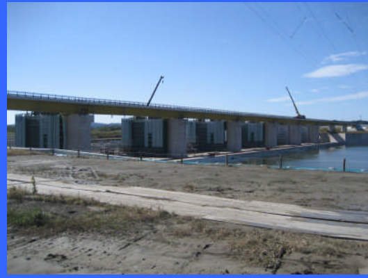
③ 右岸仮締切りより
