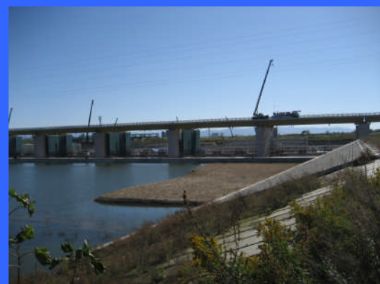
④ 左岸魚道下流より
