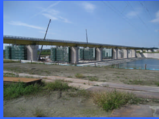
③ 右岸仮締切りより
