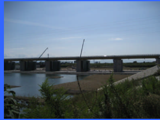
④ 左岸魚道下流より
