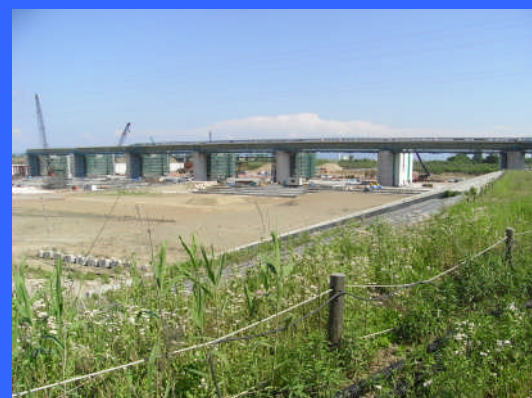
④ 左岸魚道下流より
