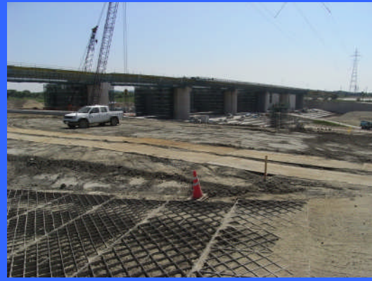
③ 右岸仮締切りより
