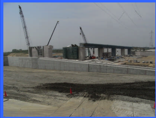
③ 右岸仮締切りより
