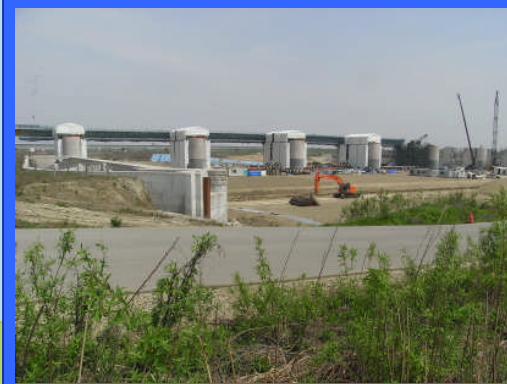
② 左岸魚道上流より
