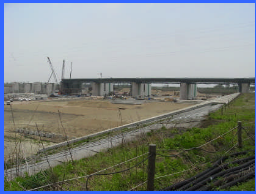
④ 左岸魚道下流より
