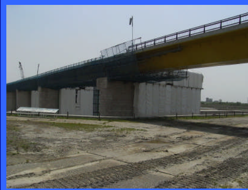
① 左岸仮締切りより
