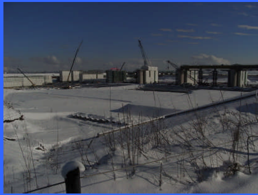
④ 左岸魚道下流より
