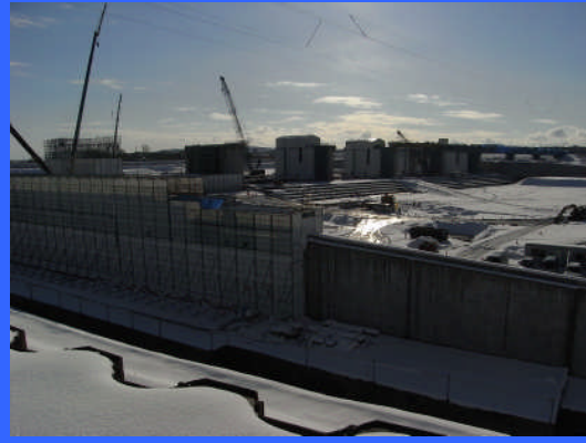
③ 右岸仮締切りより
