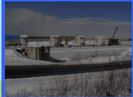
② 左岸魚道上流より
