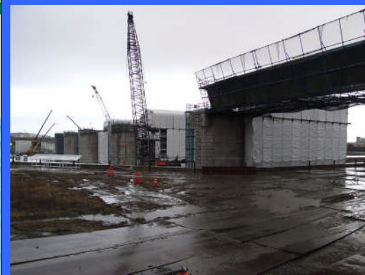
① 左岸仮締切りより
