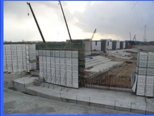
③ 右岸仮締切りより
