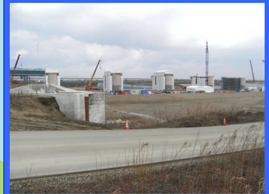
② 左岸魚道上流より
