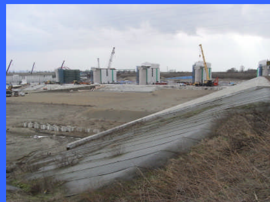
④ 左岸魚道下流より
