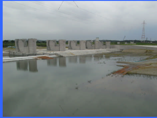
③ 右岸仮締切りより
