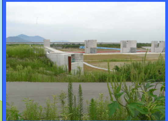
② 左岸魚道上流より
