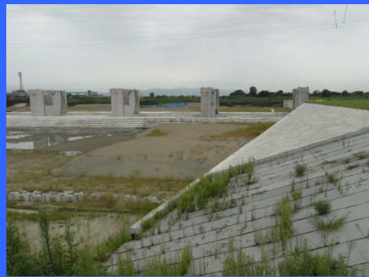
④ 左岸魚道下流より
