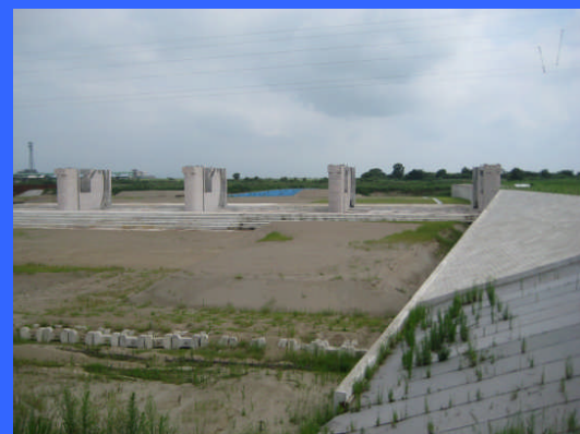
④ 左岸魚道下流より
