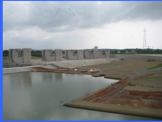
③ 右岸仮締切りより
