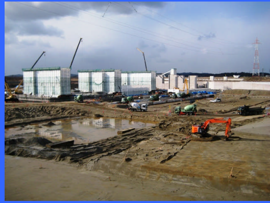
③ 右岸仮締切りより
