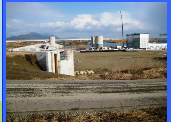
② 左岸魚道上流より
