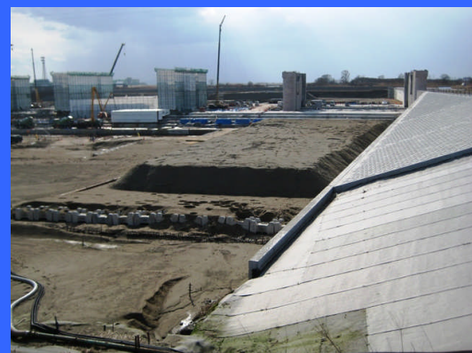
④ 左岸魚道下流より
