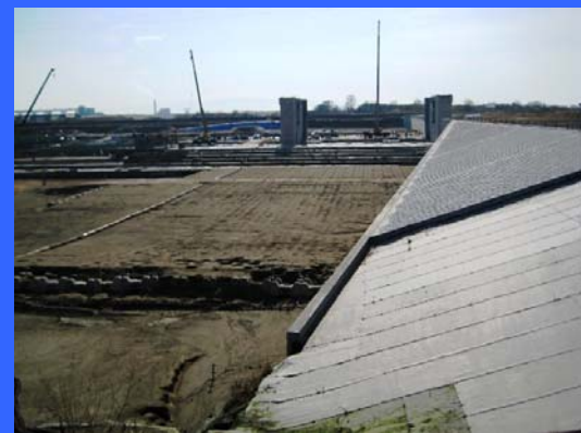
④ 左岸魚道下流より
