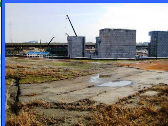
① 左岸仮締切りより
