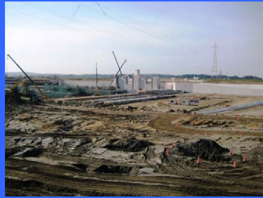
③ 右岸仮締切りより
