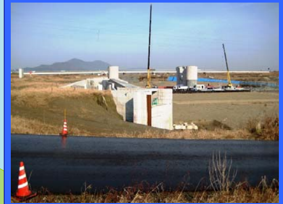
② 左岸魚道上流より
