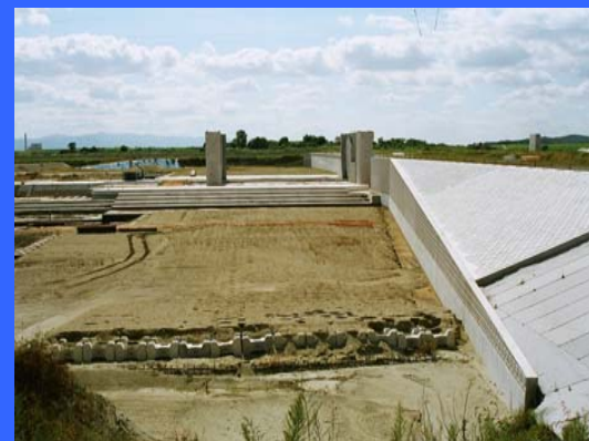
④ 左岸魚道下流より
