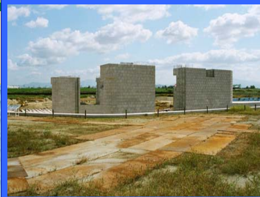
① 左岸仮締切りより
