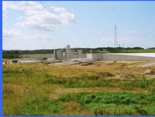
③ 右岸仮締切りより
