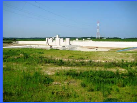
③ 右岸仮締切りより
