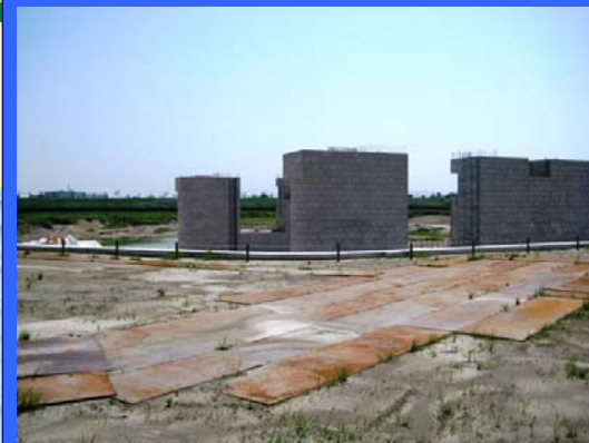
① 左岸仮締切りより
