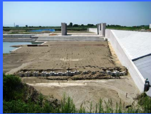
④ 左岸魚道下流より
