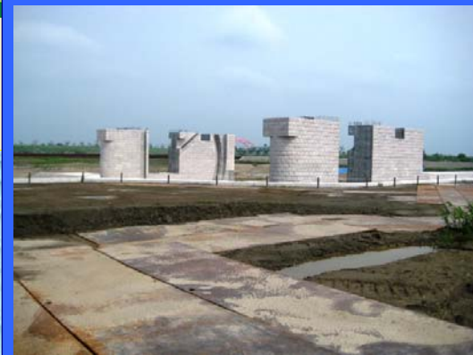
① 左岸仮締切りより
