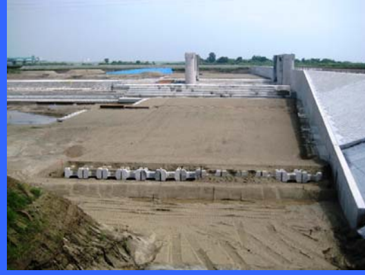
④ 左岸魚道下流より
