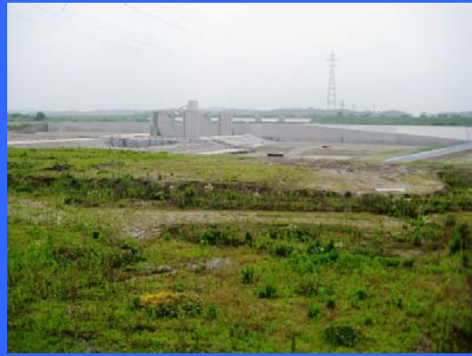
③ 右岸仮締切りより
