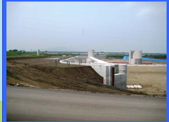
② 左岸魚道上流より
