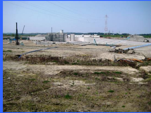
③ 右岸仮締切りより
