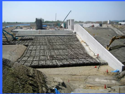
④ 左岸魚道下流より
