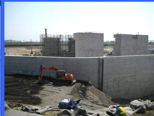
① 左岸仮締切りより
