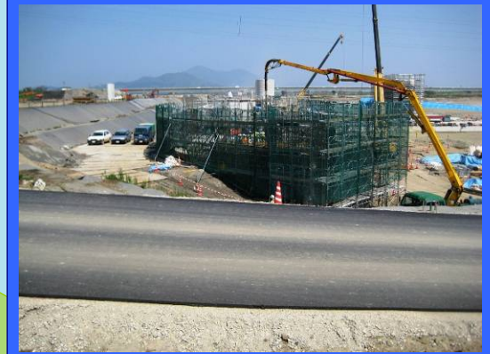
② 左岸魚道上流より
