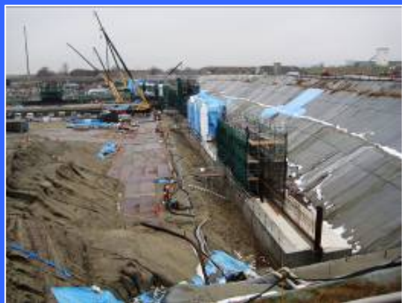
④ 左岸魚道下流より
