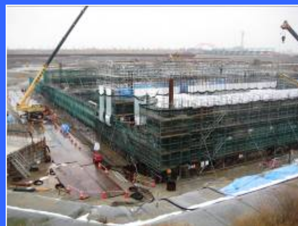
① 左岸仮締切りより
