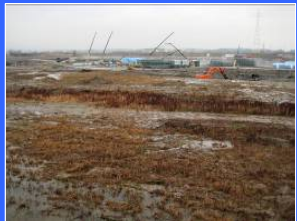
③ 右岸仮締切りより
