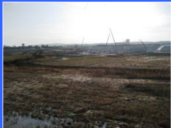
③ 右岸仮締切りより
