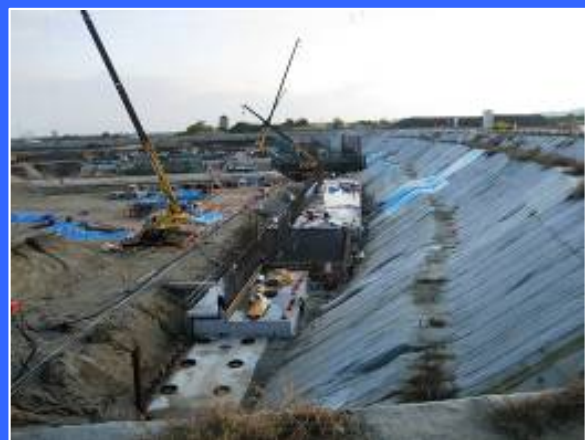
④ 左岸魚道下流より
