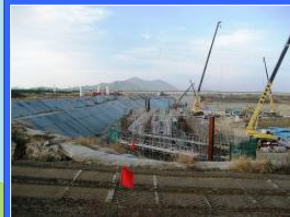
② 左岸魚道上流より
