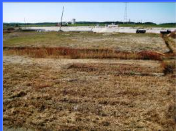
③ 右岸仮締切りより
