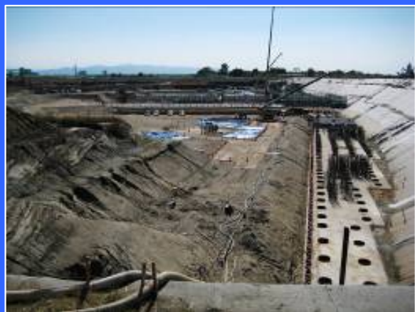
④ 左岸魚道下流より
