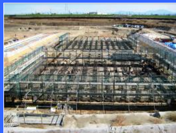
① 左岸仮締切りより
