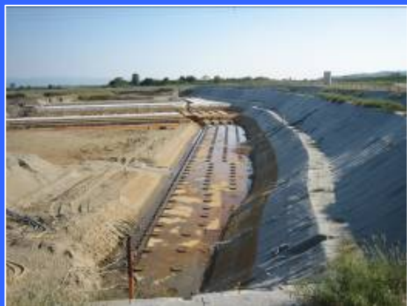
④ 左岸魚道下流より
