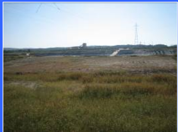
③ 右岸仮締切りより
