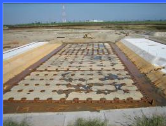
① 左岸仮締切りより
