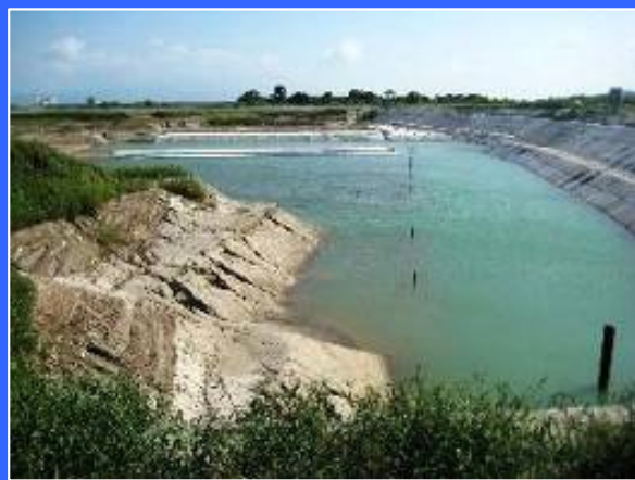
④ 左岸魚道下流より
