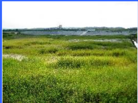
③ 右岸仮締切りより
