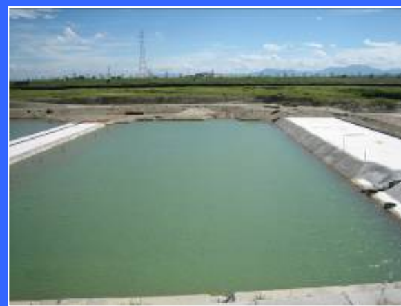
① 左岸仮締切りより
