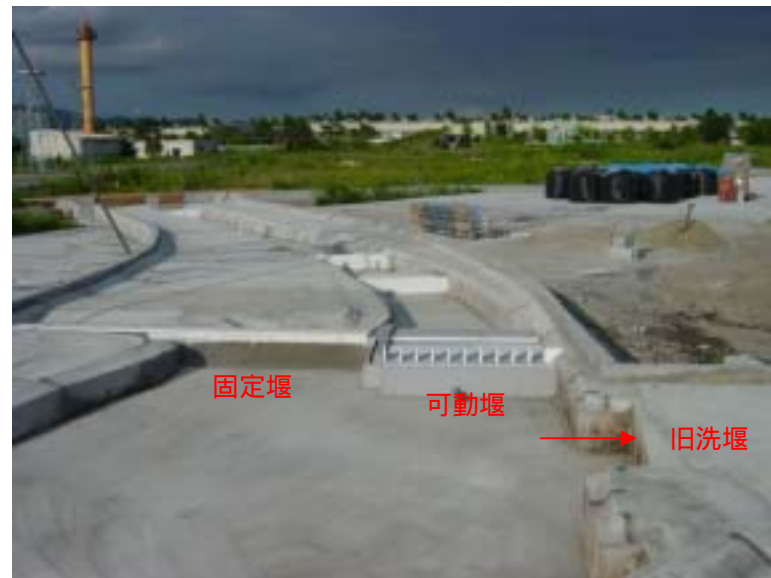
可動堰周辺状況
