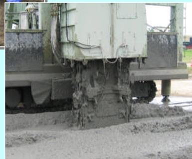
↑ 現地の土砂とベントナイト及びセメントをかき混ぜてコンクリートの壁を土中に約30mの深さでつくります。
