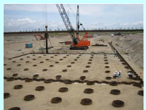
堰本体(S3,S4,S5堰柱)基礎杭 施工状況（H20.5時点）
