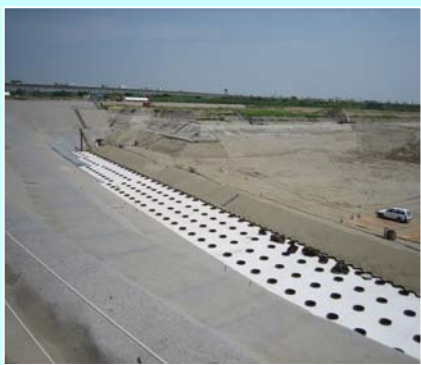
取付擁壁基礎杭施工状況 （H19.6時点）
