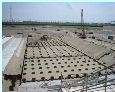
堰本体(S1,S2堰柱)基礎杭 施工状況（H19.6時点）
