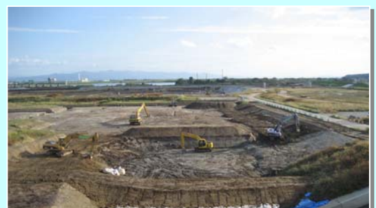
河道掘削工事の状況
