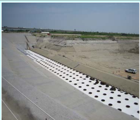
取付擁壁基礎杭施工状況 (H19.6時点)
