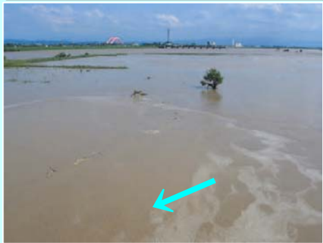
調査箇所を含む高水敷が冠水(H18.7.20)
