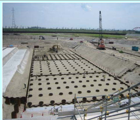
堰本体基礎杭施工状況 (H19.6時点)
