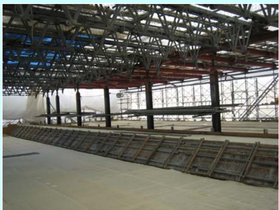
雪寒仮囲い内の状況（コンクリート養生） （G2中央床版部：H20.1.31撮影）
