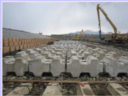
根固(異形)ブロック据付
