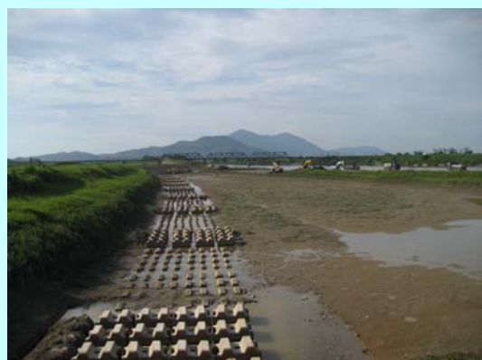
完成後1年3ヶ月後の状況
