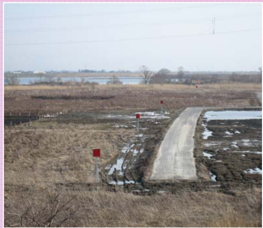
工事前の様子
