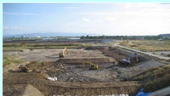
工事中の状況
