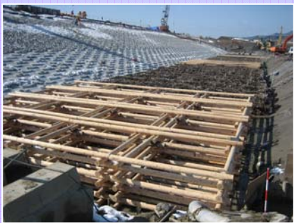
粗朶沈床・木工沈床組立
