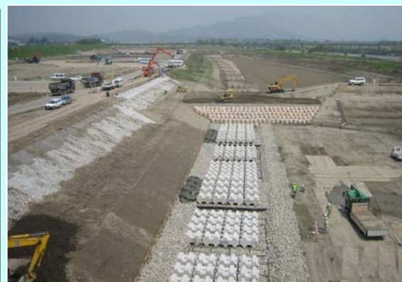
低水護岸完成
