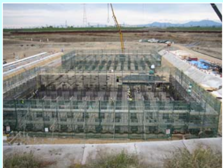
コンクリート打設のための準備中
