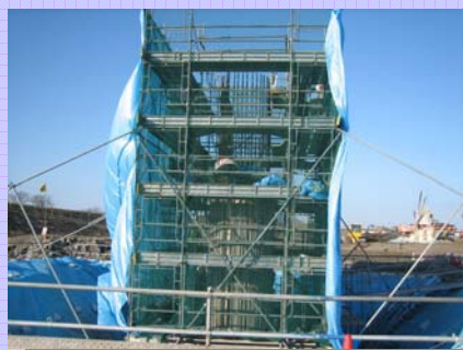
躯体施工状況
