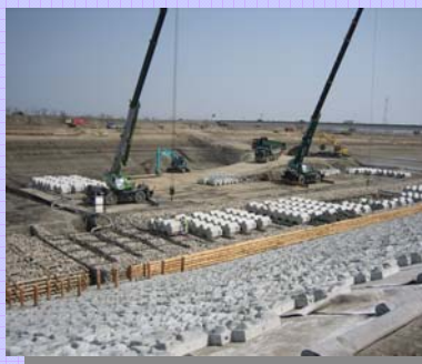
根固（異形）ブロック据付
