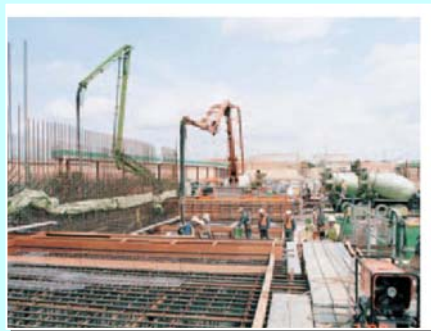
コンクリート打設状況（ポンプ車）
