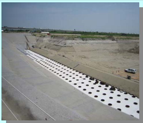
取付擁壁基礎杭施工状況 (H19.6時点)
