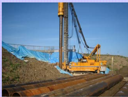
基礎杭(鋼管杭)施工
