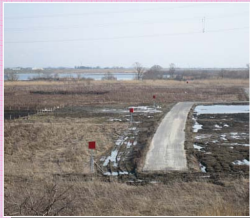
工事前の様子
