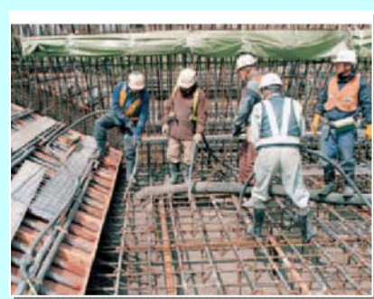
バイブレータによる締固め
