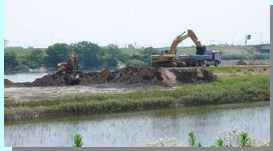
工事中の状況
