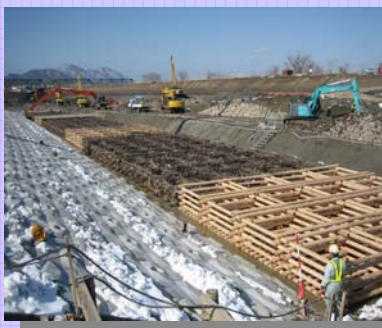
粗朶沈床・木工沈床組立
