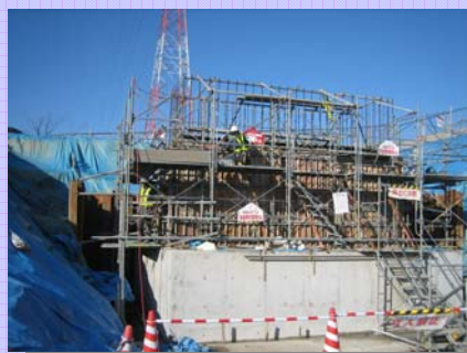
躯体施工状況
