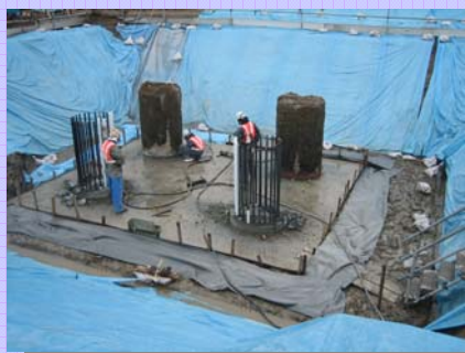
基礎杭(場所打杭)施工
