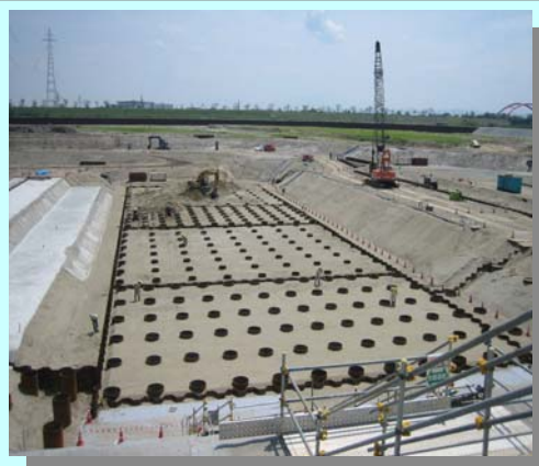
堰本體基礎杭施工状況 (H19.6時点)
