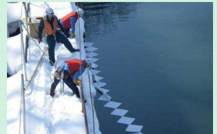
油を吸着マットを用いて回収作業
