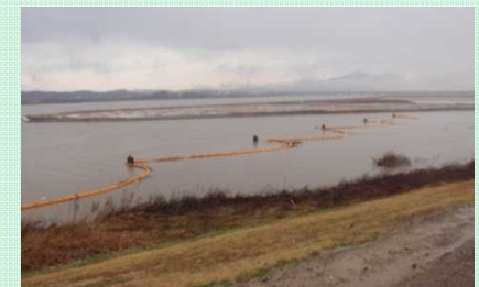
油を吸着マットを用いて回収作業
