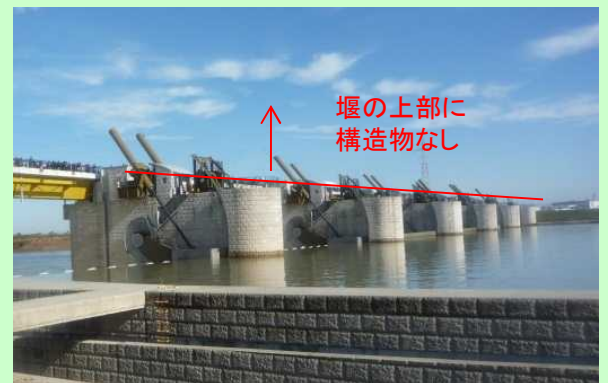
可動堰（ラジアルゲート）
