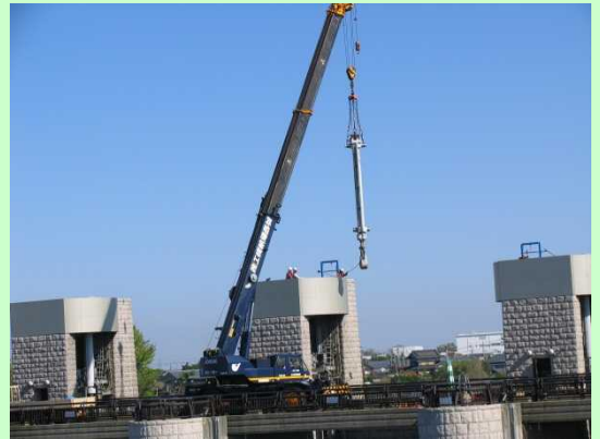
油圧シリンダーの取り外し (長さ:約7.5m、重さ:約7t)
