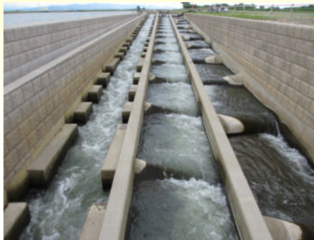
左:底部阻流角材式 中央:傾斜隔壁式 右:傾斜隔壁式(ハーフコーン型)
