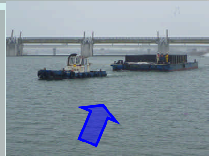
掘削土砂は別の土砂運搬船で運び出します。
