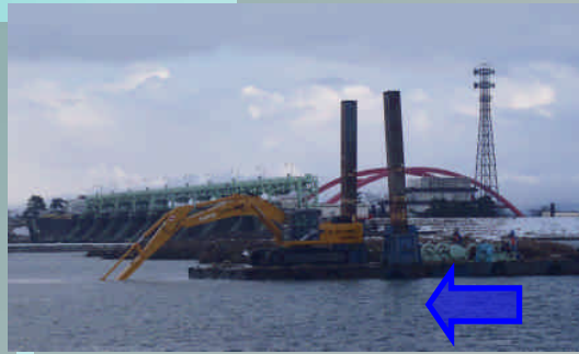
台船上でバックホウを操作し、流れを阻害する部分の土砂を掘削します。
