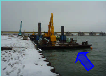
左岸側にて組み立てた台船にバックホウを乗せた様子です。
