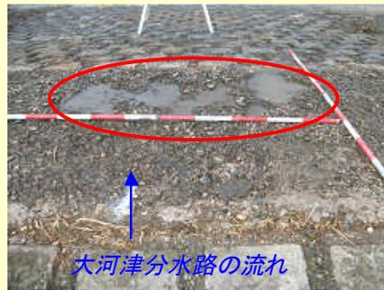
固定堰天端部の表面の摩耗状況
