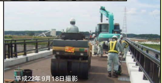
管理橋舗装 施工状況
